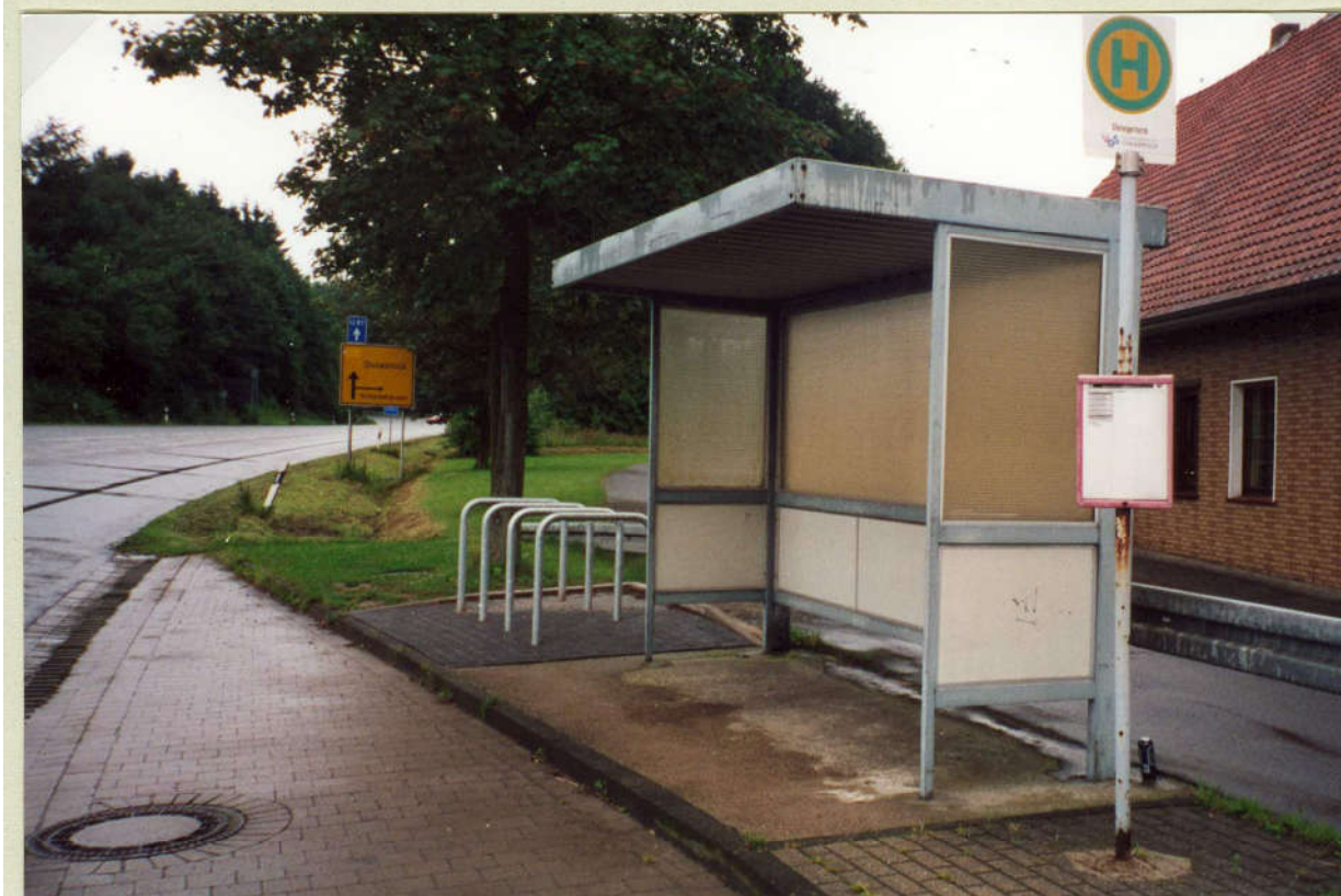
Steinigerturm Ost (B 68)
